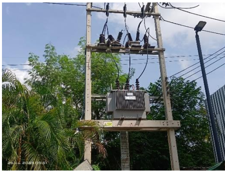
ภาพที่ 2.2-29 หม้อแปลงไฟฟ้าของโครงการ
