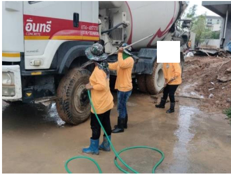
ภาพที่ 2.2-4 การทำความสะอาดล้อรถบรรทุกและอุปกรณ์สำหรับฉีดล้างล้อ
