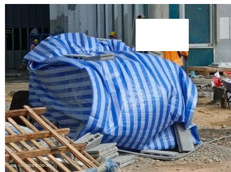
ภาพที่ 2.2-2 การปิดคลุมกองวัสดุ/พื้นที่จัดเก็บกองวัสดุ
