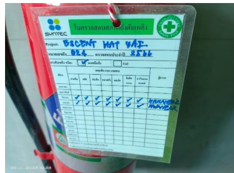
ภาพที่ 2.2-14 การตรวจสอบถังดับเพลิง
